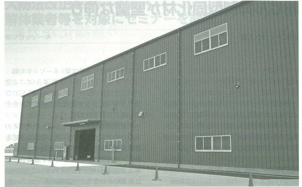
泉州プラントの建屋
