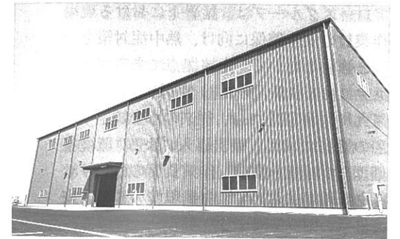
日量1000m 3 規模の処理能力を持つ泉州プラントの建屋
